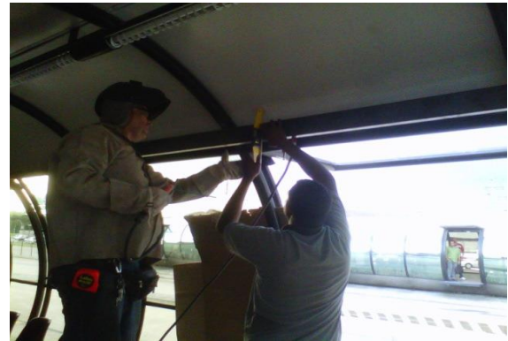
Solda de estrutura auxiliar
